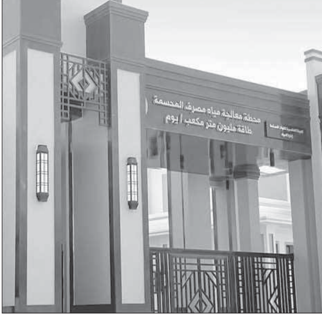
محطة معالجة مياه الصرف بالمحسمة
