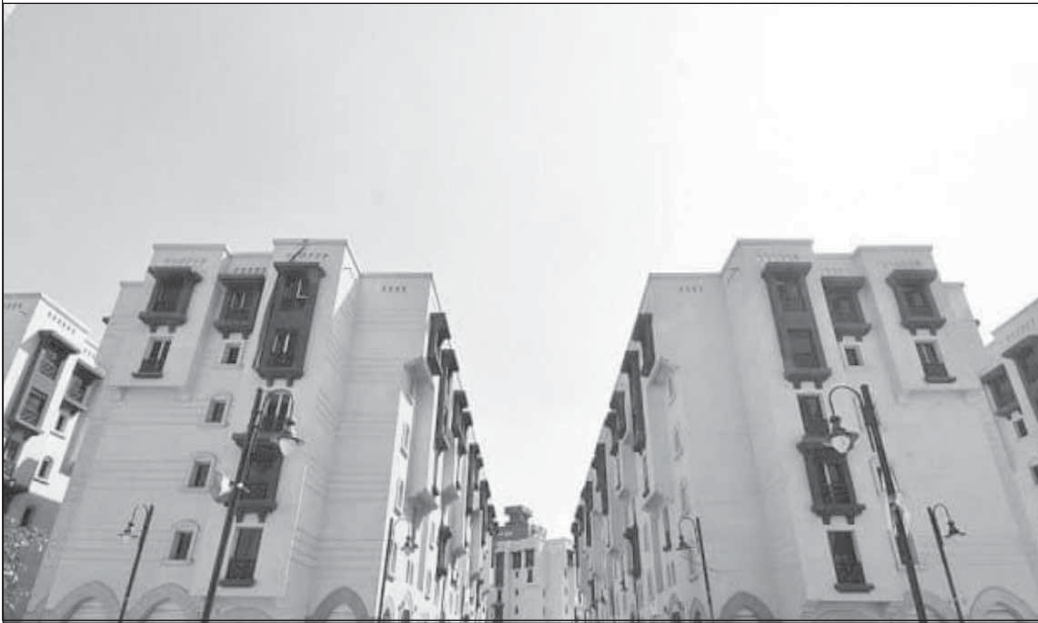
«الصورة قبل وبعد التطوير»
